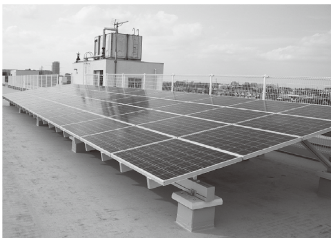
10kWの発電能力のある太陽光発電設備が設置されました
