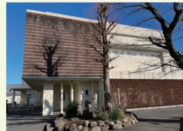
平成23年度に完成した屋内運動場。 令和5年度からは猪方こどもクラブ が設置される。
