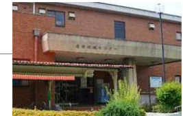
南部地域センター図書室
